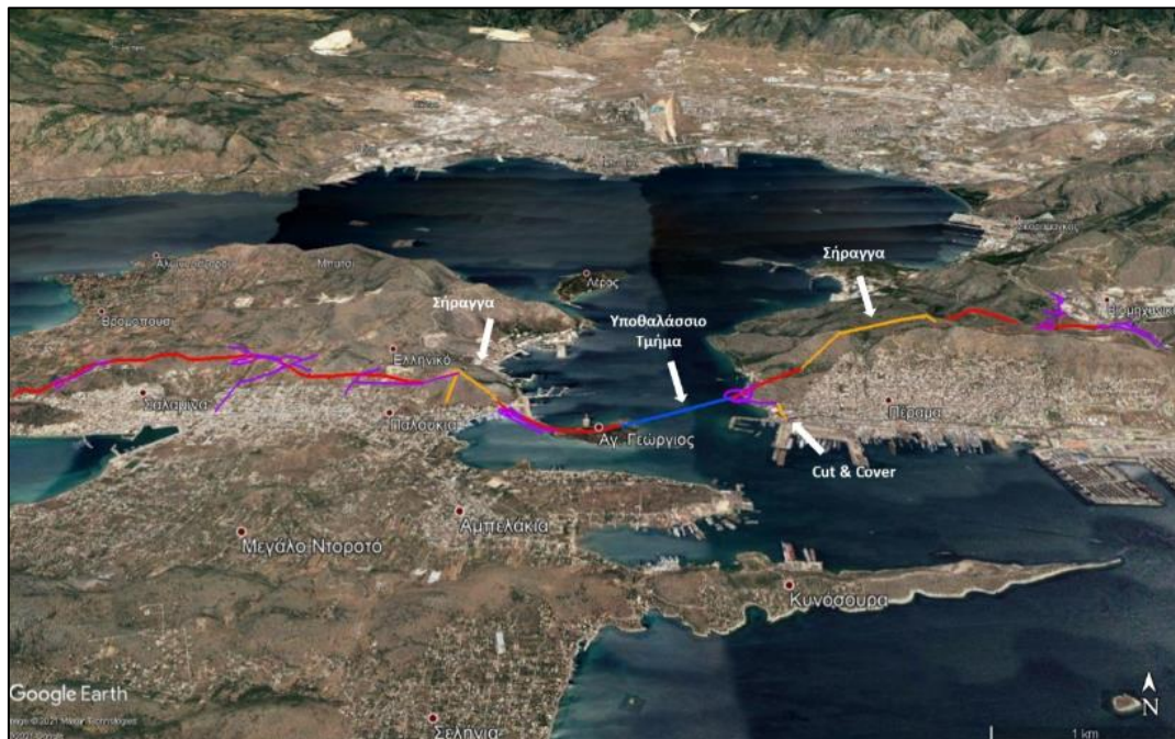
Εικόνα 7: Υποθαλάσσια ζεύξη Σαλαμίνας-Περάματος στο χώρο (Πηγή: yrodomes)
